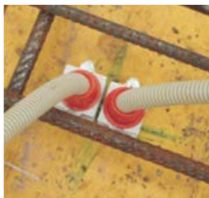
Приклад використання кінцевої втулки та муфти.
