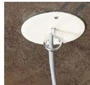
Монтажна коробка KBT... з кришкою V 68 S з провідником і гачком для люстри KBP....
